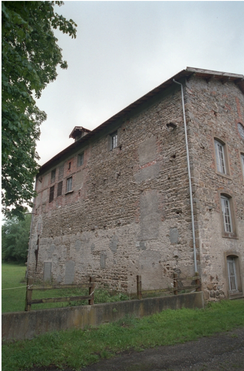
Vue d'ensemble de la façade latérale gauche du moulin.
