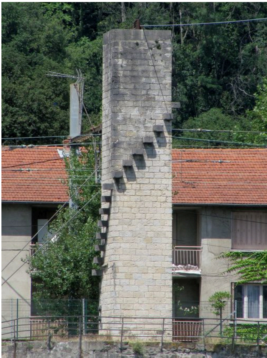
Pile droite, face est, vue générale (depuis la rive gauche)
