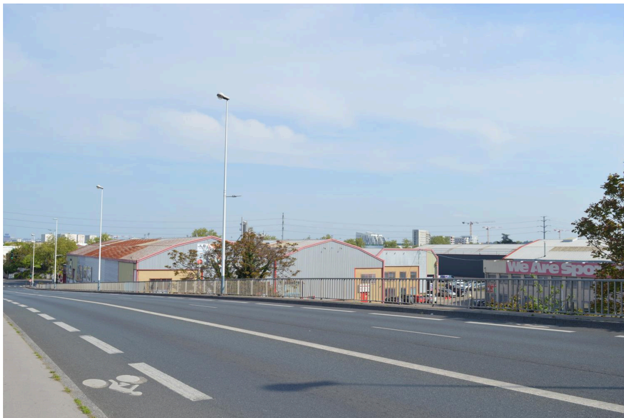
Aciéries de Longwy en 2022 vues depuis l'autopont
