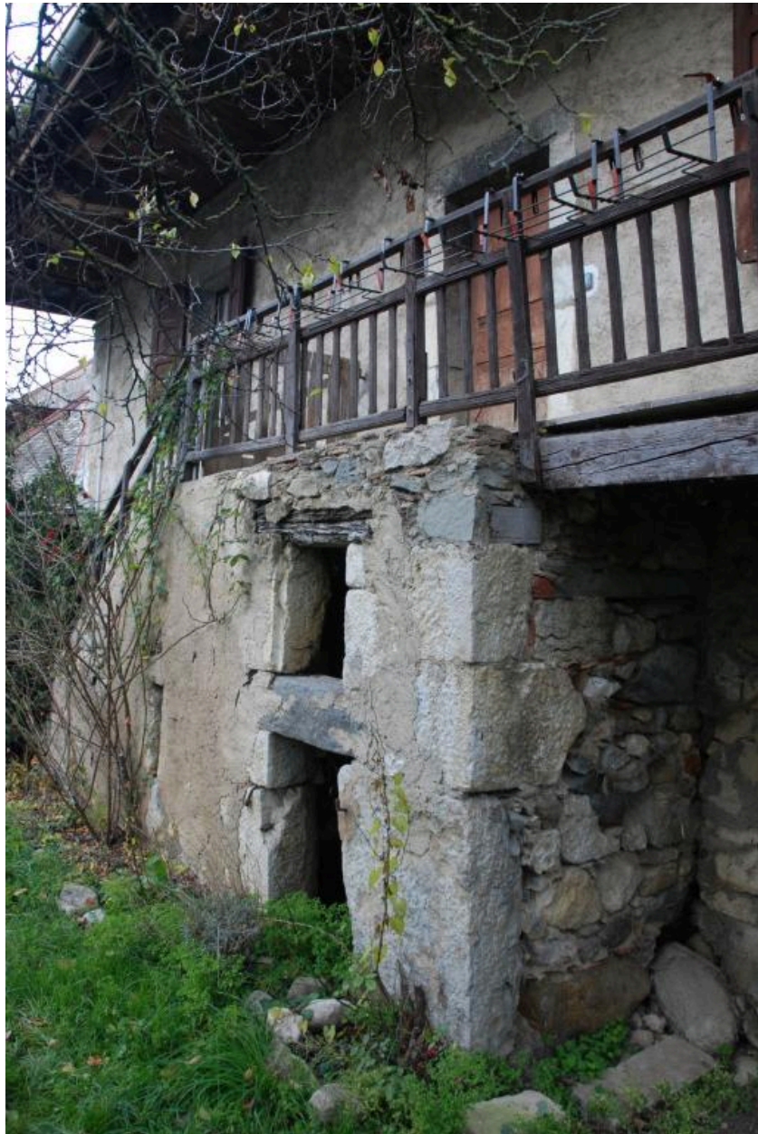
Maison, élévation principale : détail de la remise sous l'escalier.
