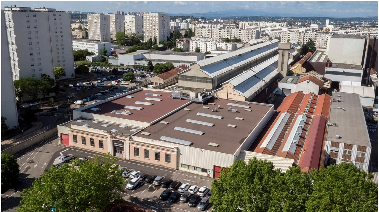
Vue d'ensemble est du site (drone)
