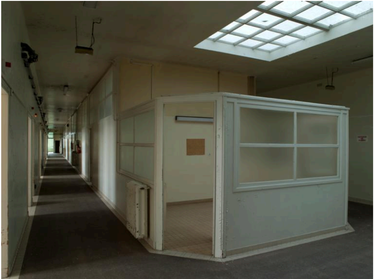
Hôtel-Dieu de Clermont-Ferrand. L'hôtel-Dieu, corps de bâtiment sud, intérieur du dernier étage.
