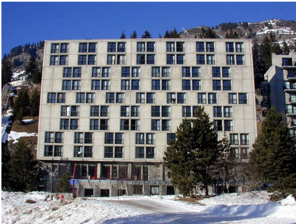
Façade principale au sud
