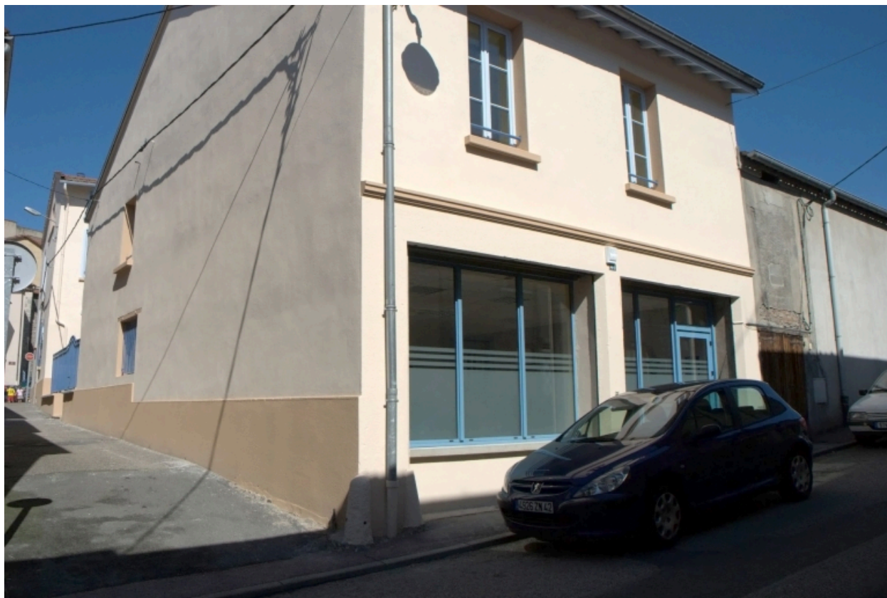
Îlot 2. Saint-Jean (rue) 40 / Saint-Jean (traversière) 1 / Roanne (rue de) 17. Vue générale de la façade sur rue avec arrière de la maison sur la traversière Saint-Jean.
