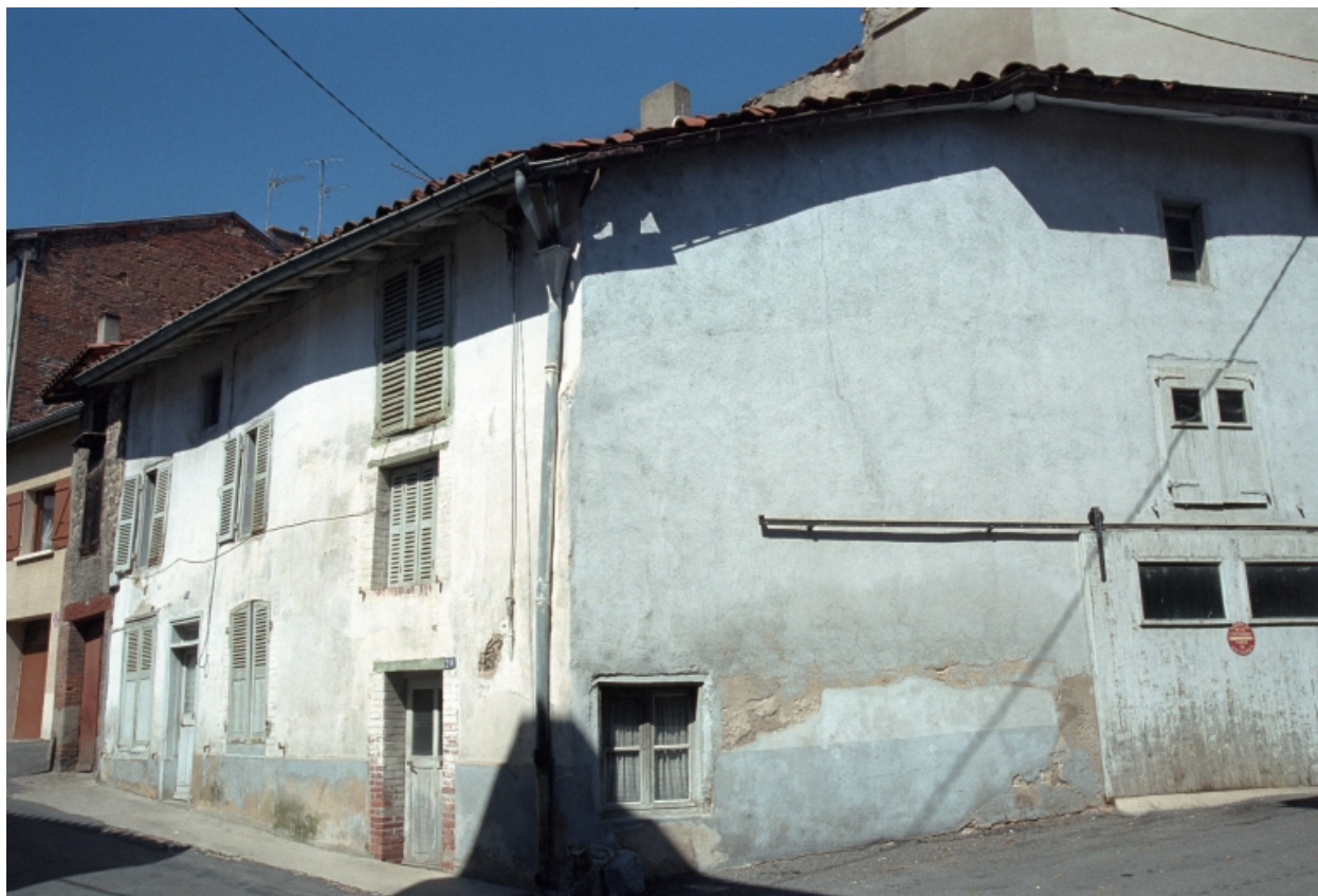
Boën, îlot 14, Gustave Labrosse (rue) 20. Vue générale de la façade sur rue.
