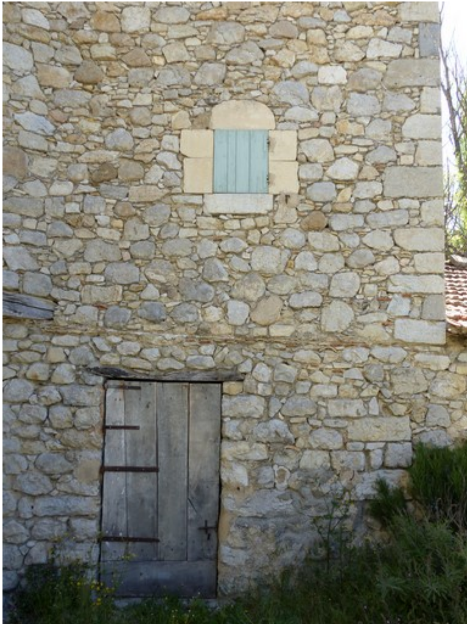
Partie sud-est. Elévation ouest, partie nord. Surélévation.
