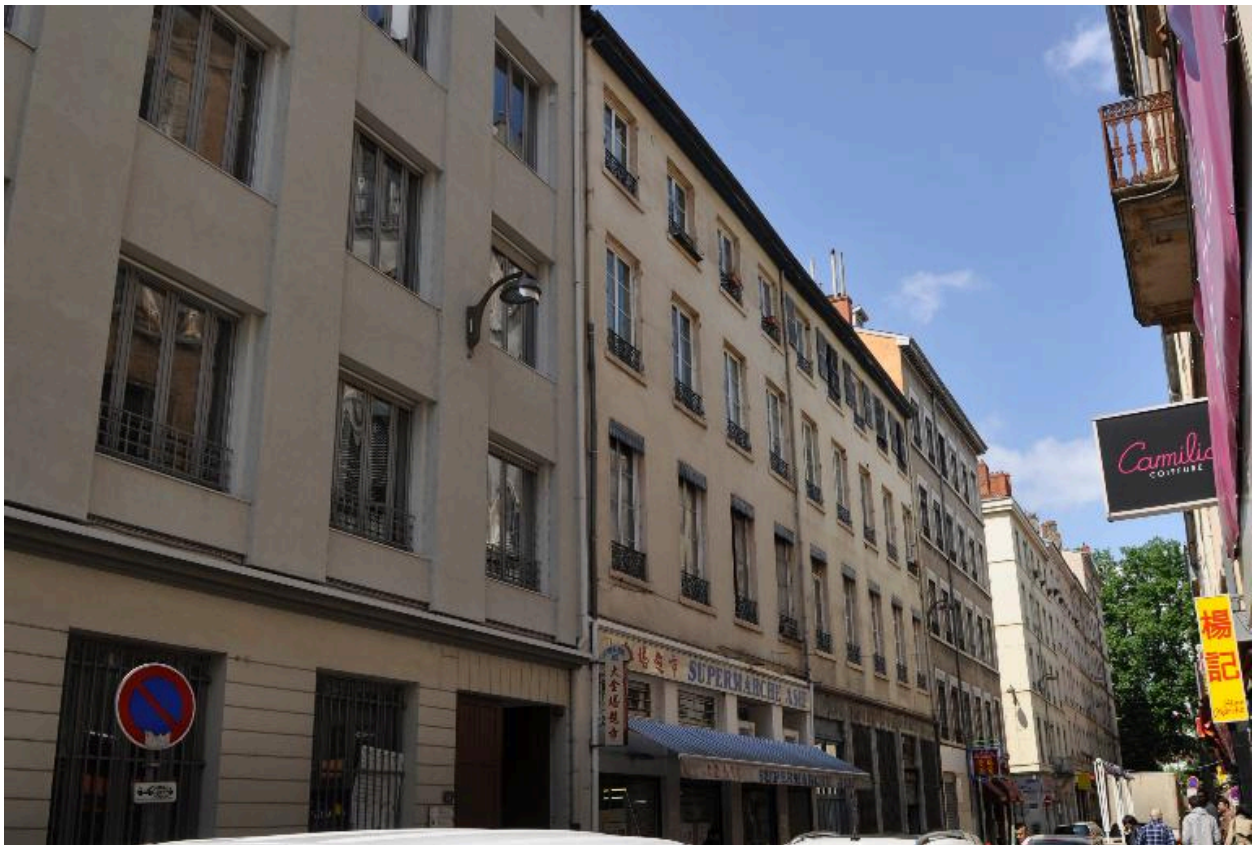
Vue d'ensemble, élévation sur rue
