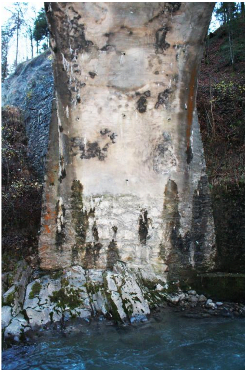
Pont de Couvaloup, détails voute et culée
