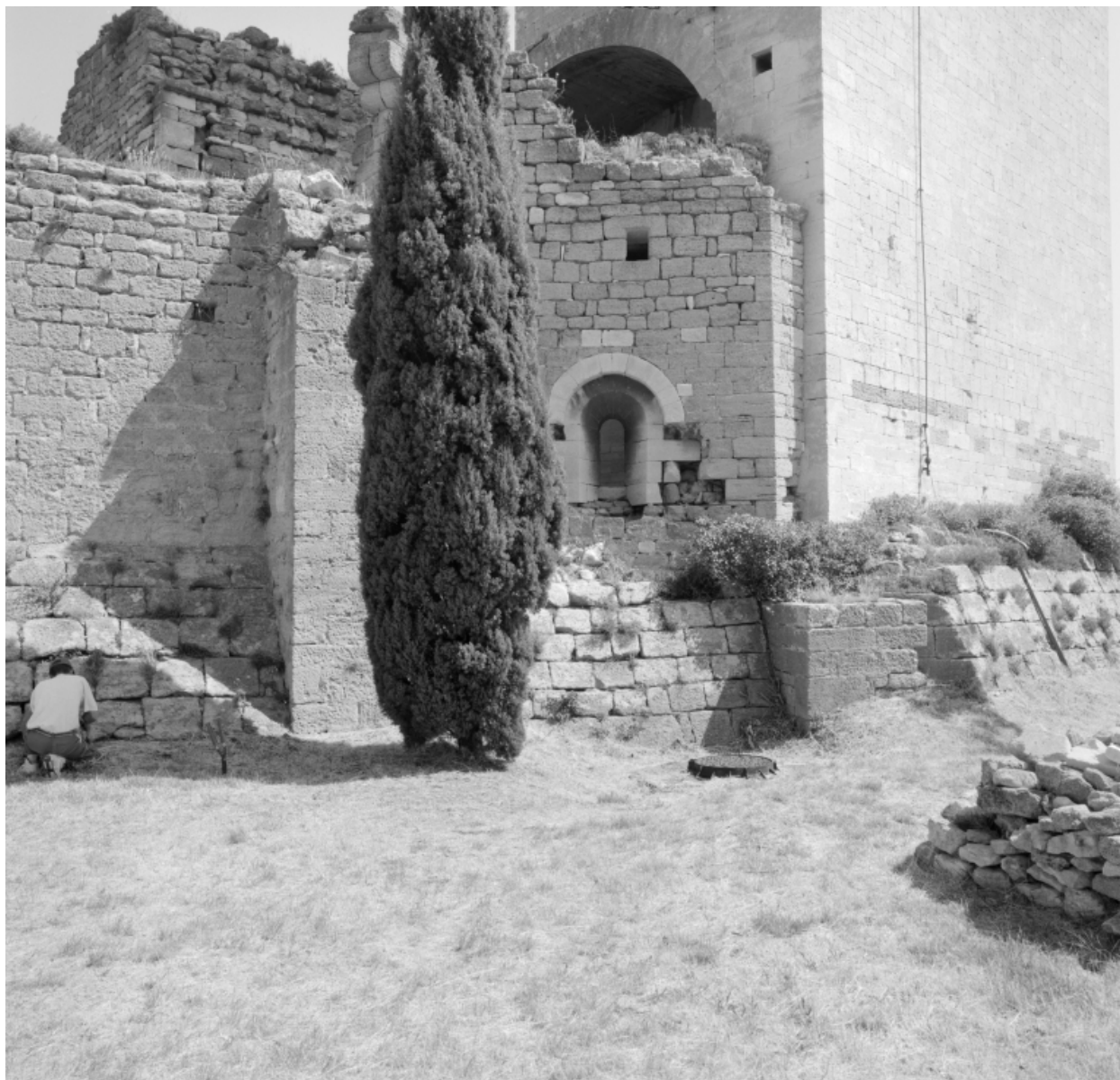
Mur-bouclier sud et fenêtre.
