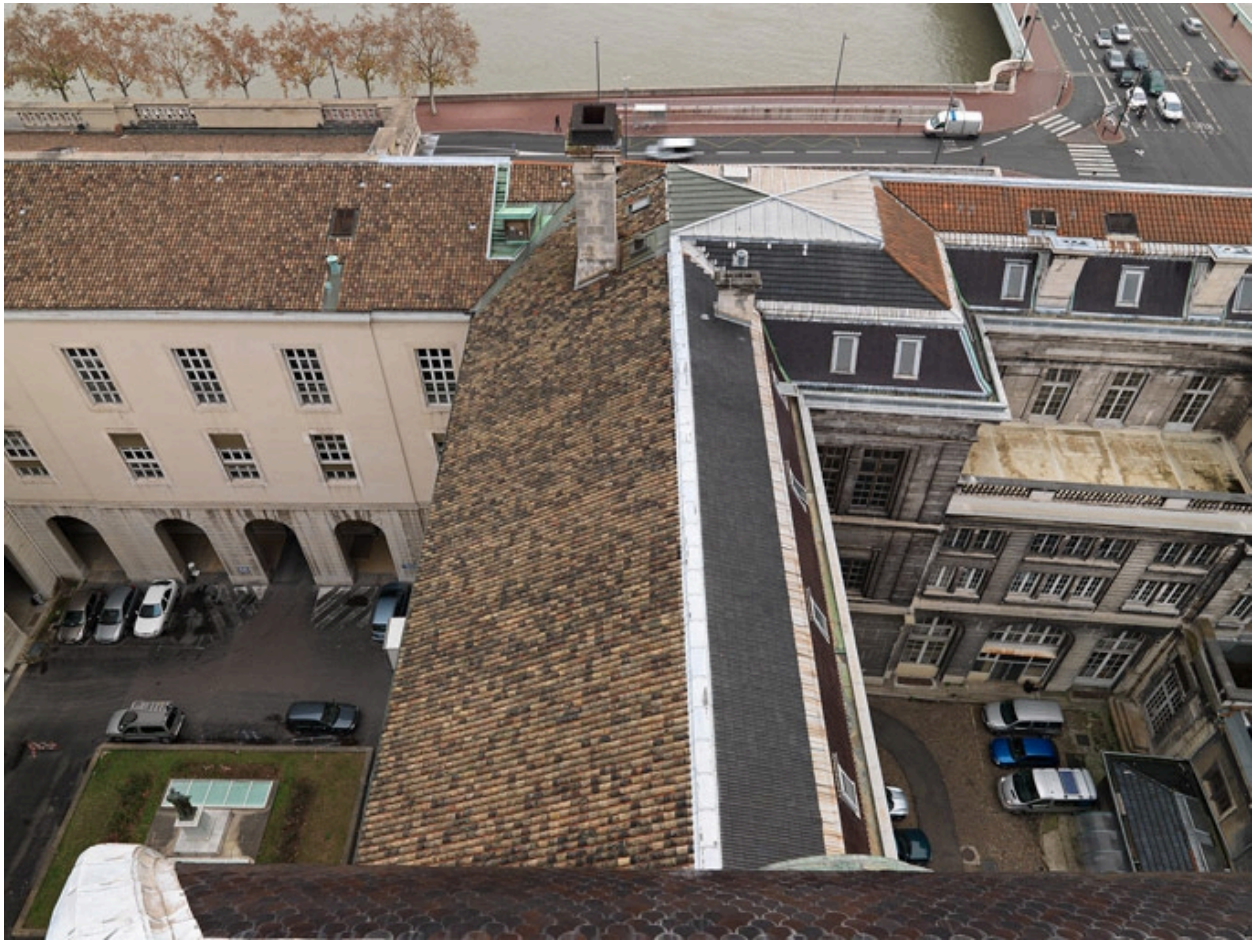
Bâtiment C. Vue du toit depuis le dôme Pascalon
