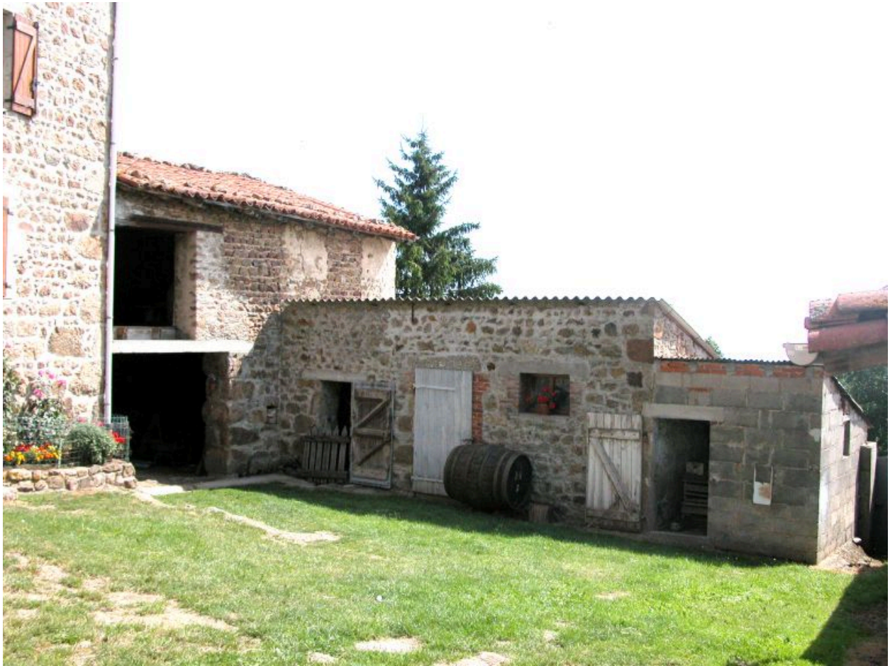
Vue d'ensemble des communs situés sur le côté est de la cour de la ferme.
