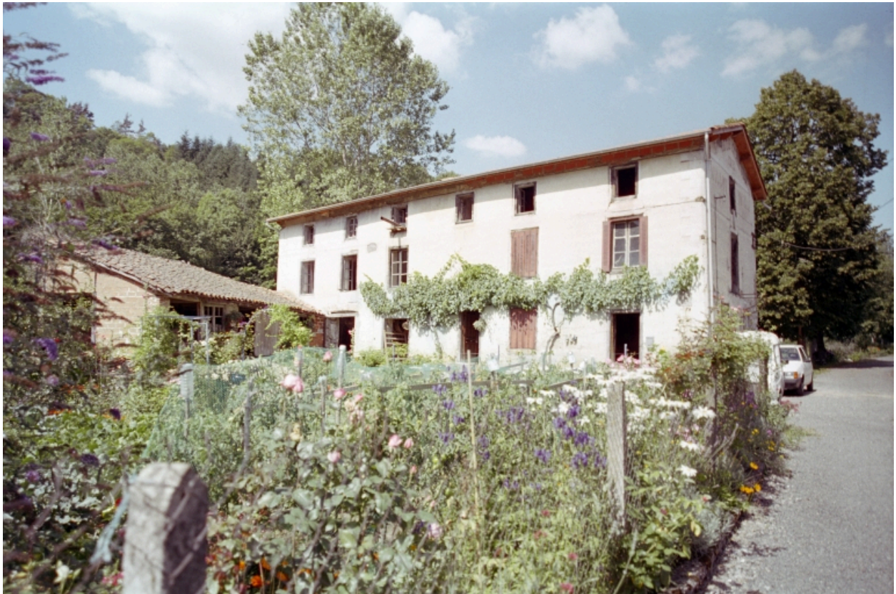
Vue d'ensemble du moulin, de trois quarts.
