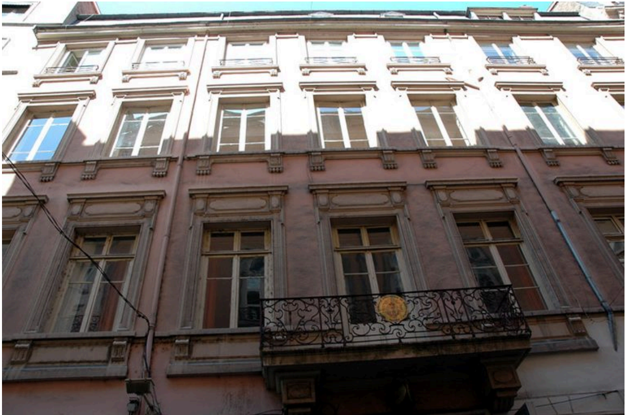
Lotissement concerté : 12 rue Emile-Zola, façade de l'immeuble
