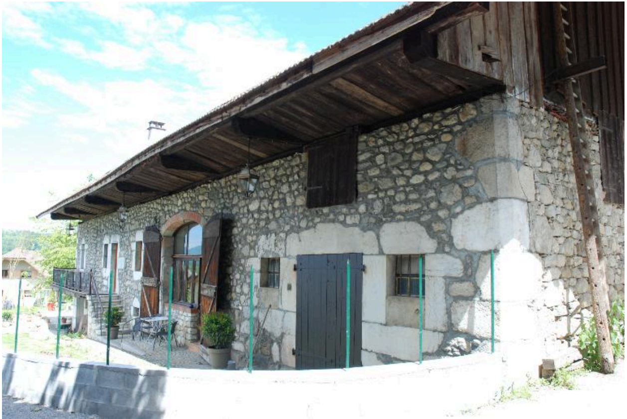
Vue d'ensemble, partie grange-étable.
