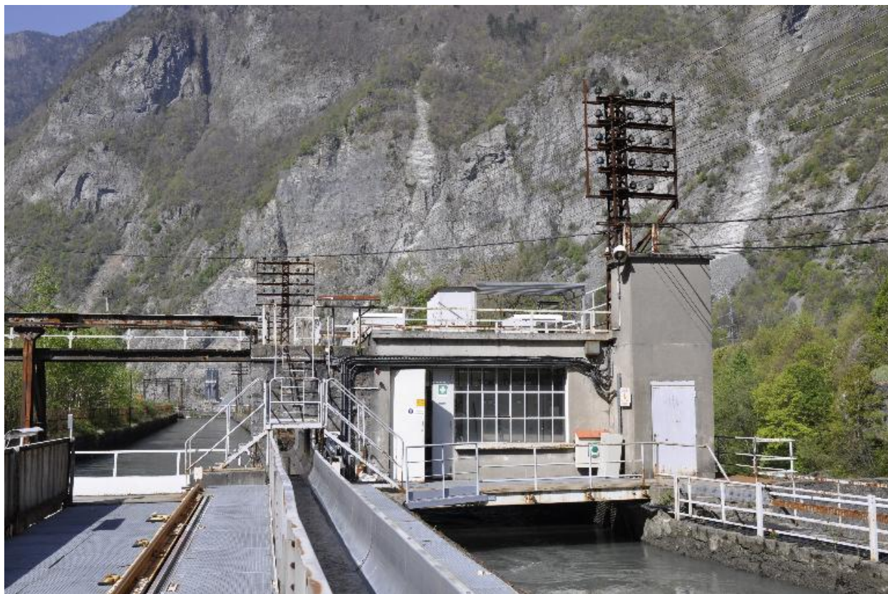
Vue des installations du barrage de Rioupéroux
