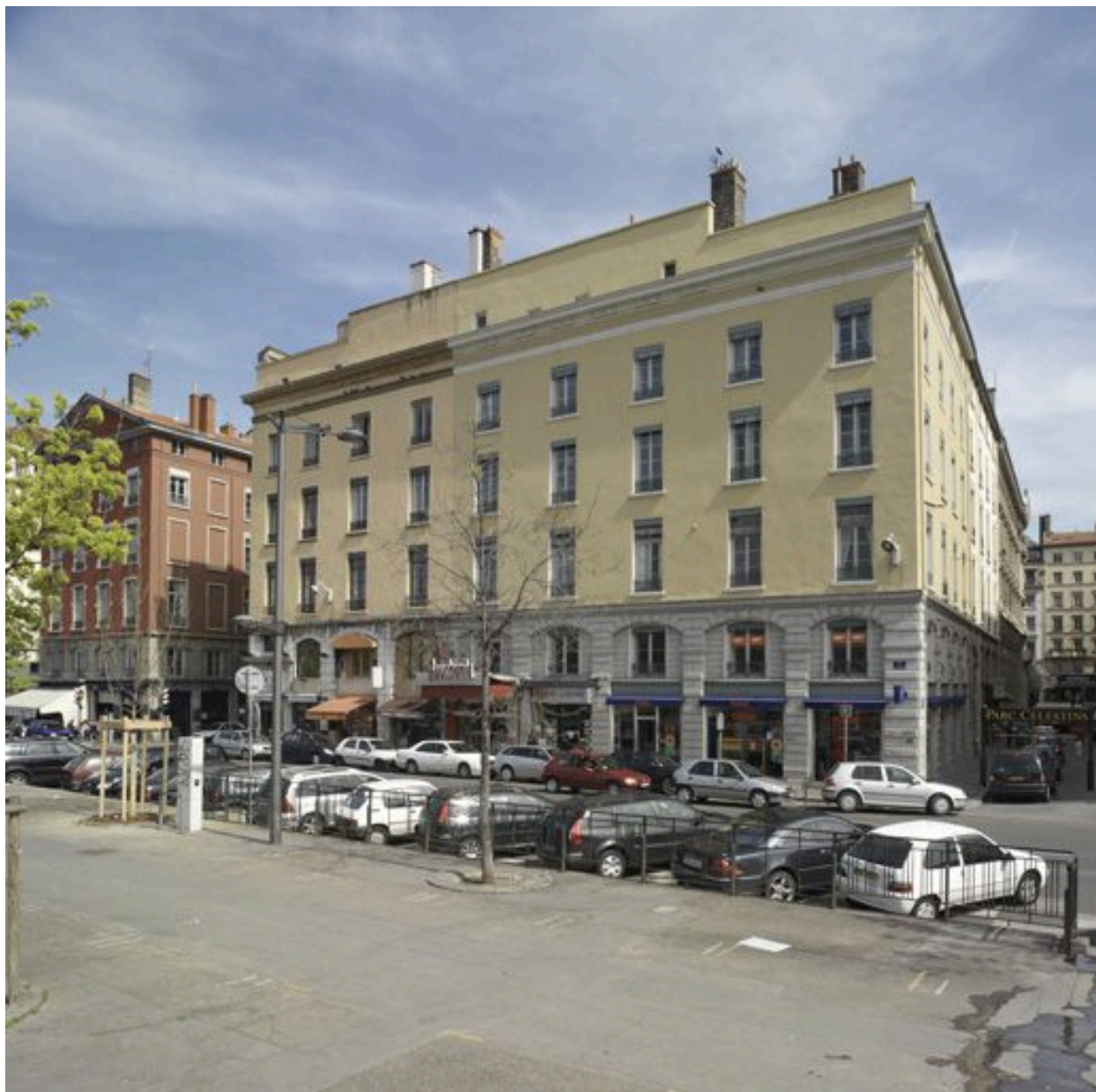
Couvent : 8 et 9 quai des Célestins, vue partielle
