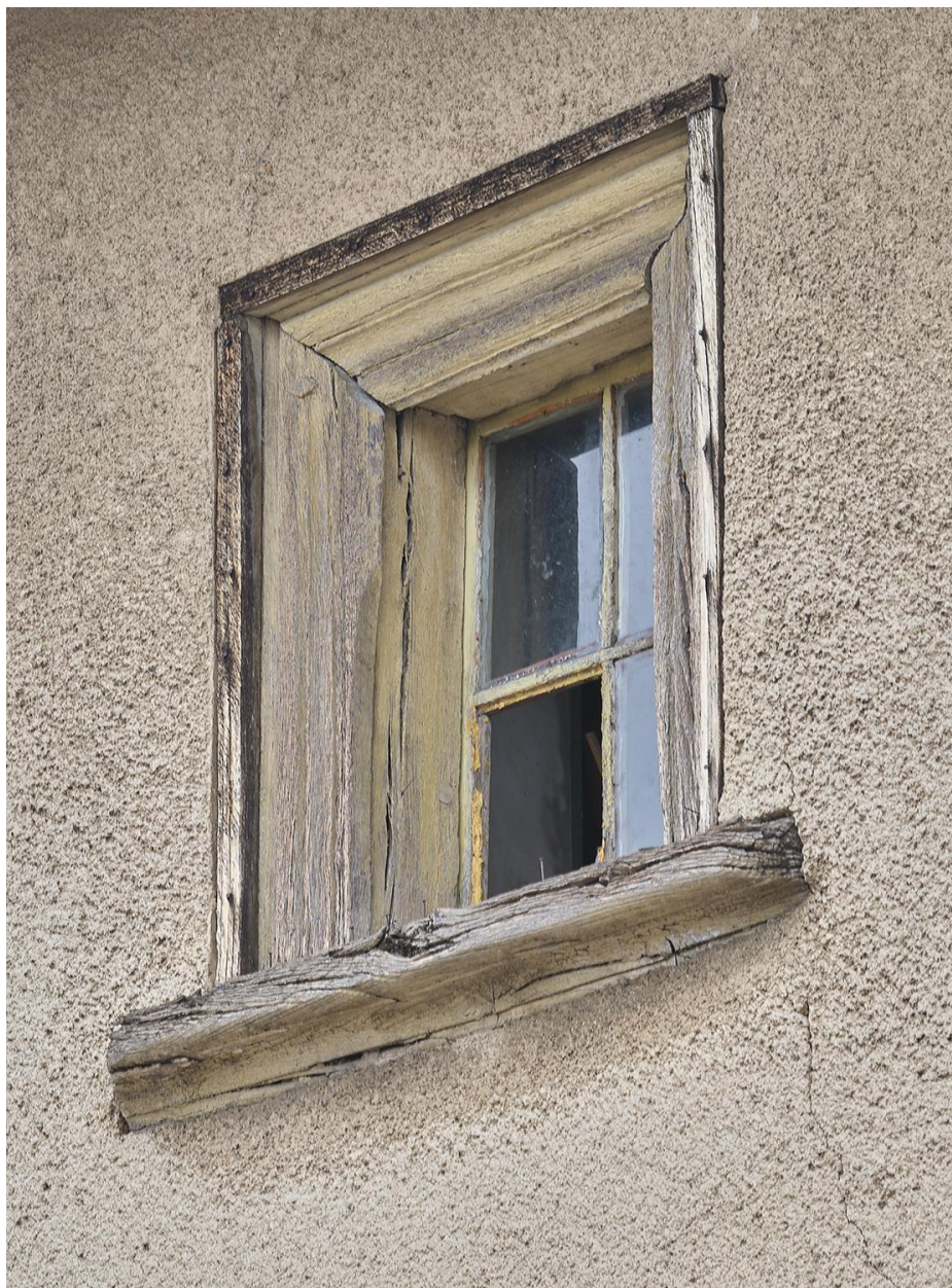
Elévation sud de la maison, étage de comble, détail d'une baie à encadrement bois.
