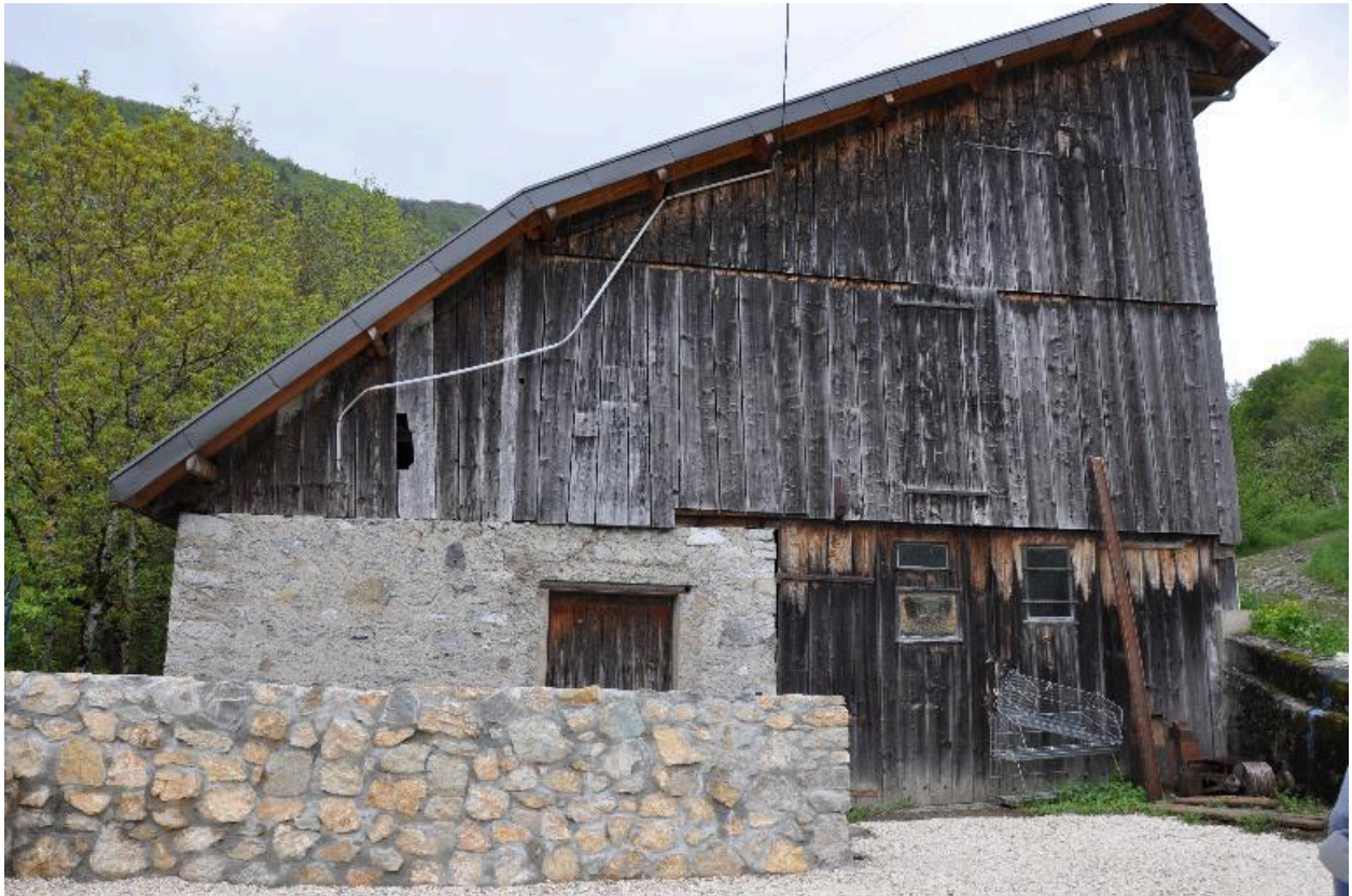
Vue de la façade sud de l'atelier.
