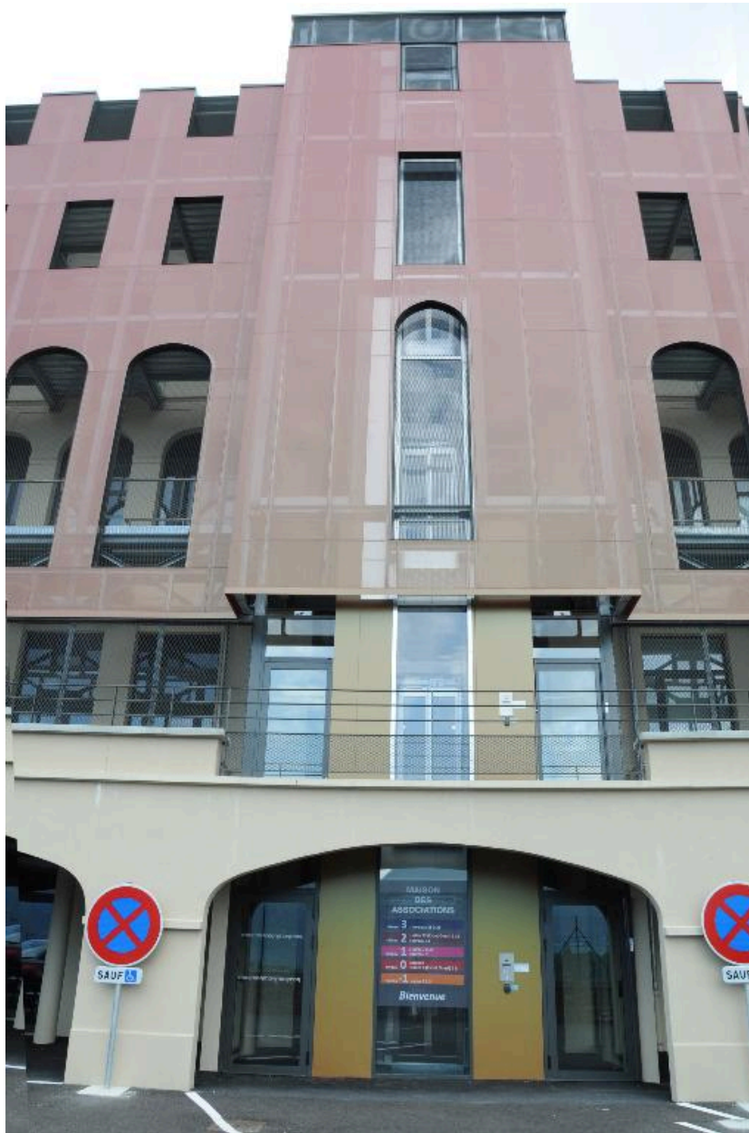
Cage d'ascenseur sur élévation ouest
