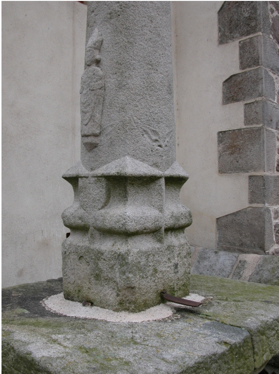
Détail du dé et du fût : lame métallique fichée dans le dé, base prismatique, saint Martin (depuis le nord-est).
