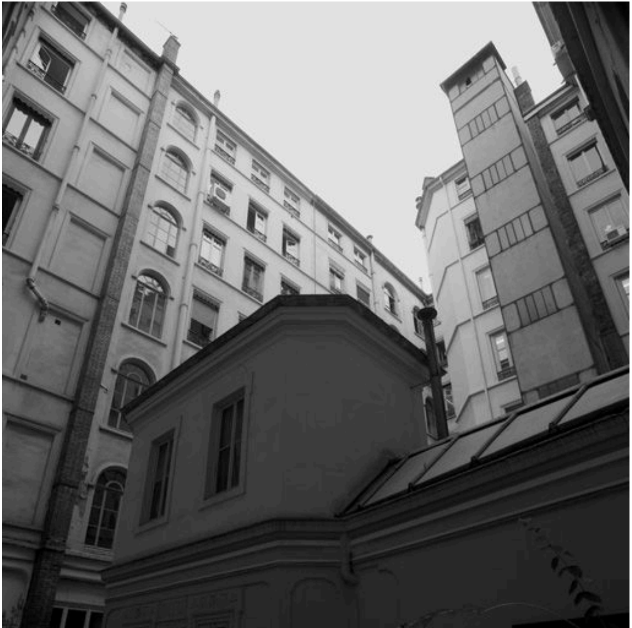
Vue de la conciergerie depuis le sud-est
