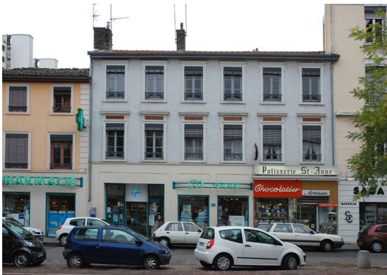
Elévation antérieure du 228 rue Paul-Bert
