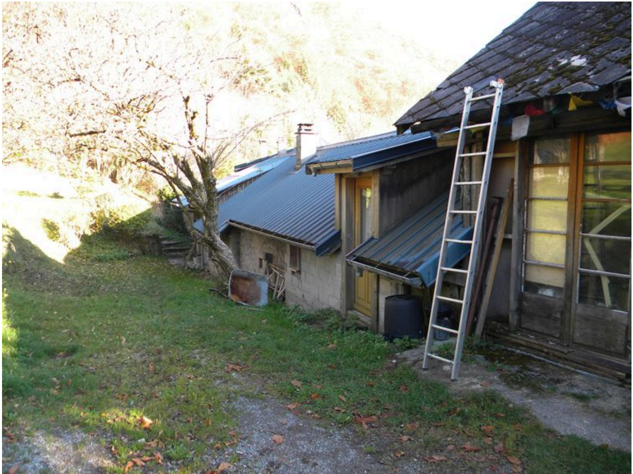
Vue de la façade arrière semi-enterrée.
