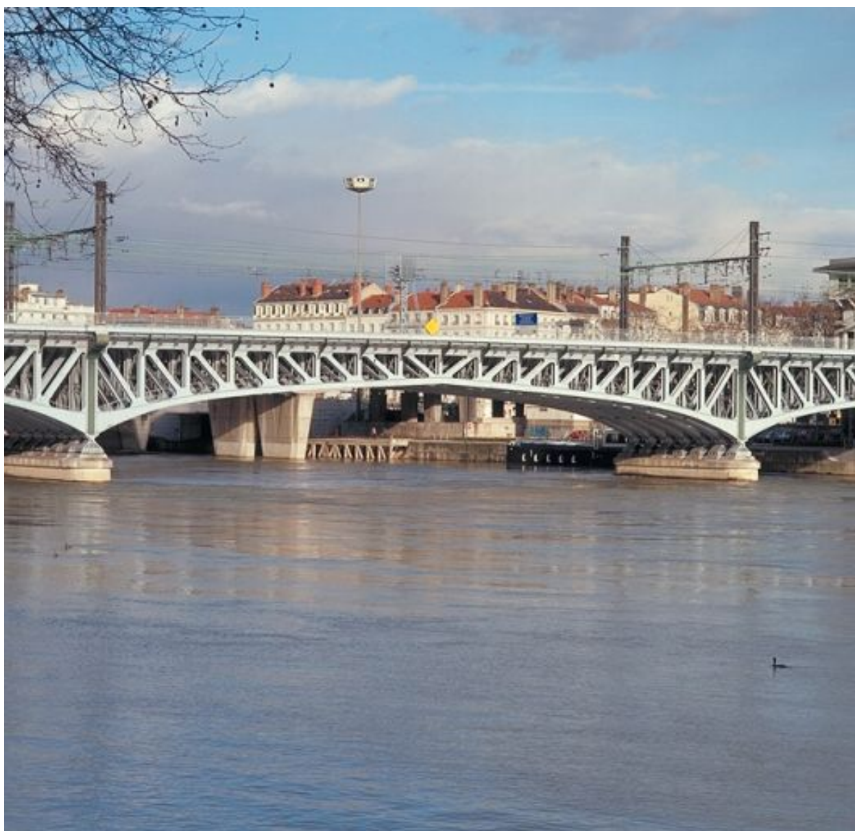
La travée centrale
