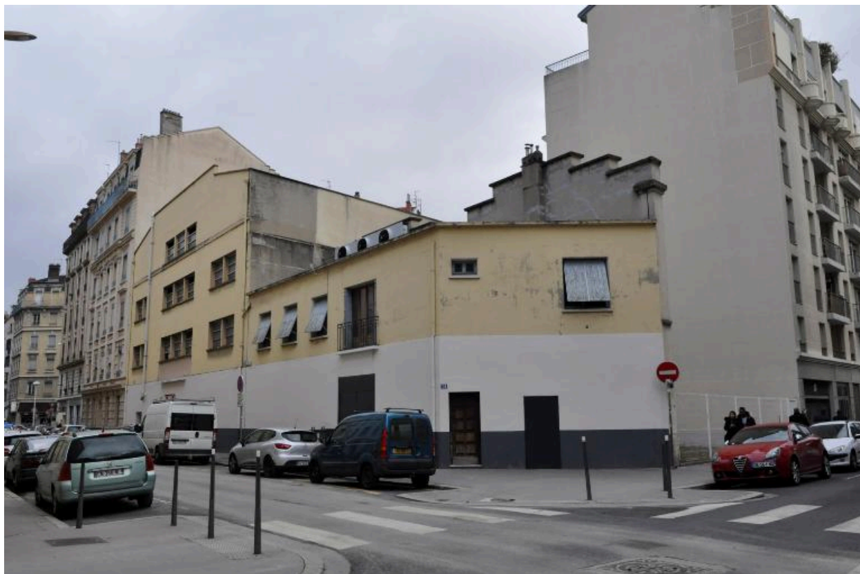
Vue d'ensemble du site, sud-est angle rue Saint-Jérôme-Jaboulay.
