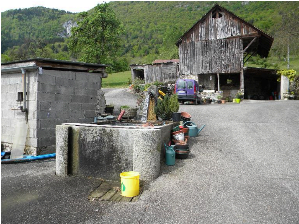
Vue d'ensemble du bassin chemin de la ferme.
