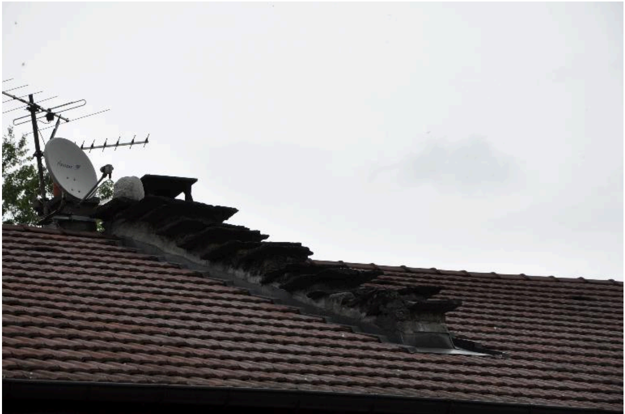
Détail sur un pignon découvert à redents
