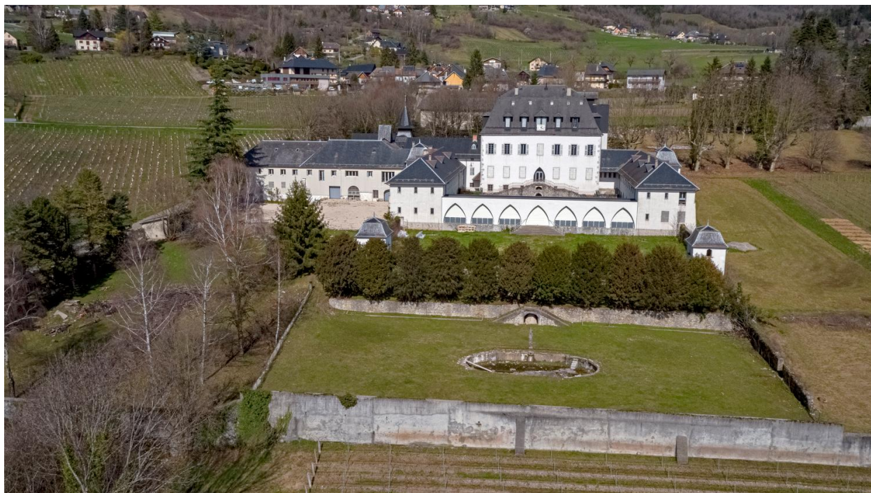
Vue générale dans l'axe du bâtiment principal et du jardin, du sud-est.
