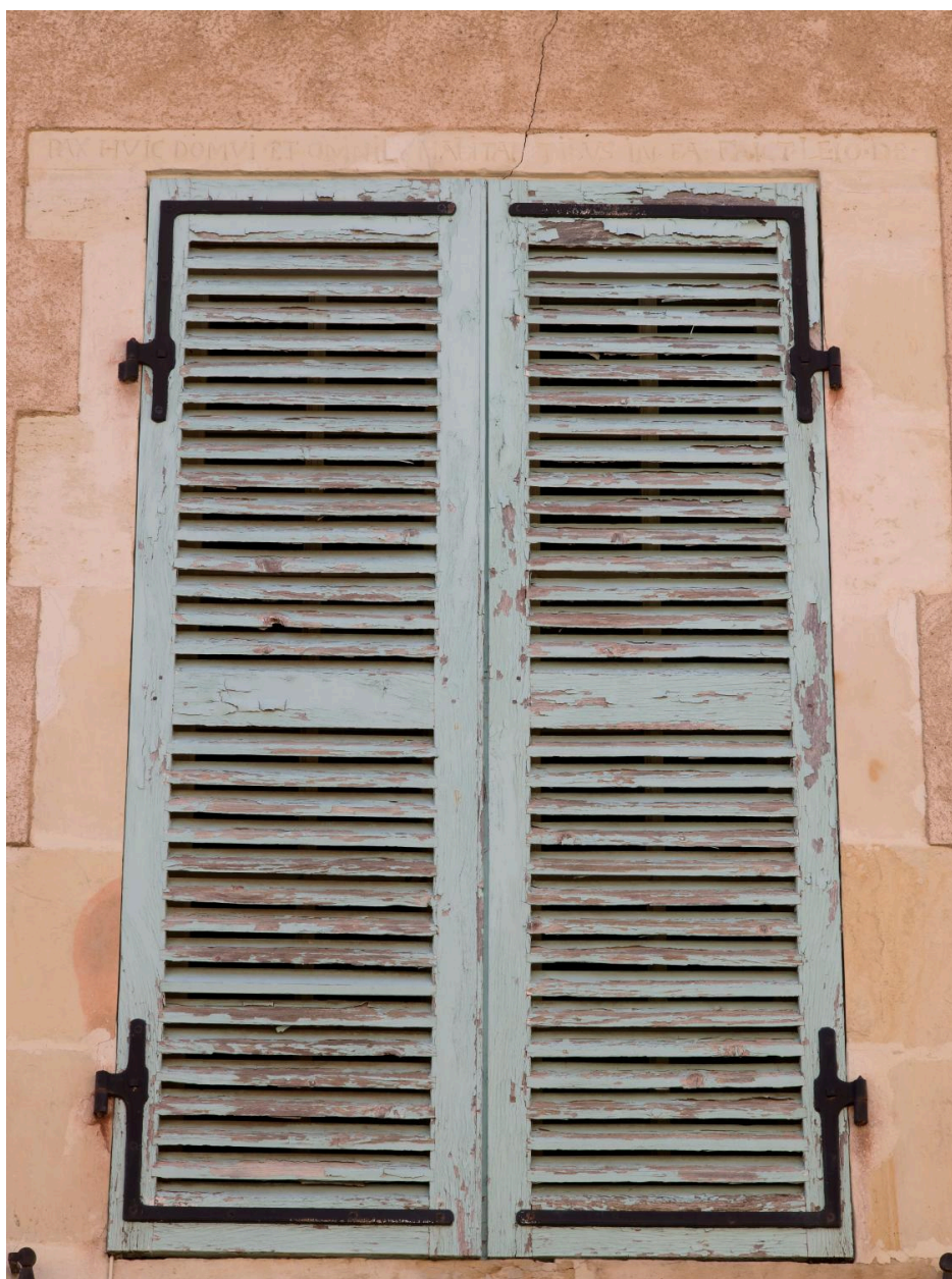
Vue de la fenêtre du 1er étage de la maison du 4, rue d'Allier, parcelle cadastrale B01 : 58.
