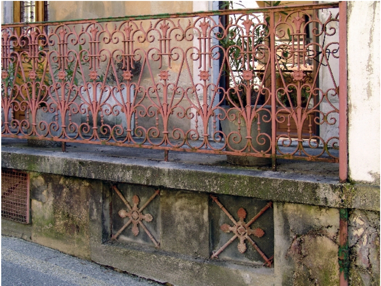
Détail du garde-corps
