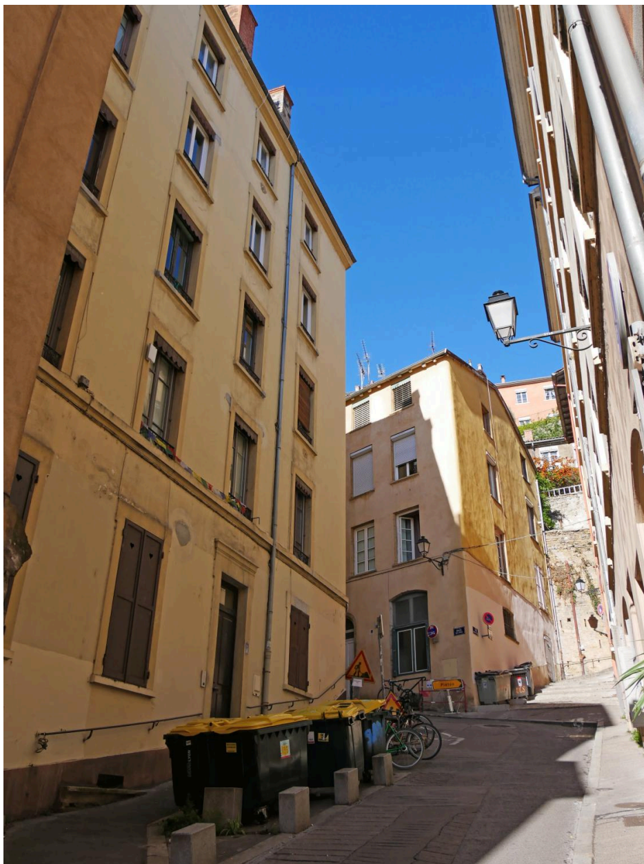
Façade nord, Logements de la société des logements économiques 1890
