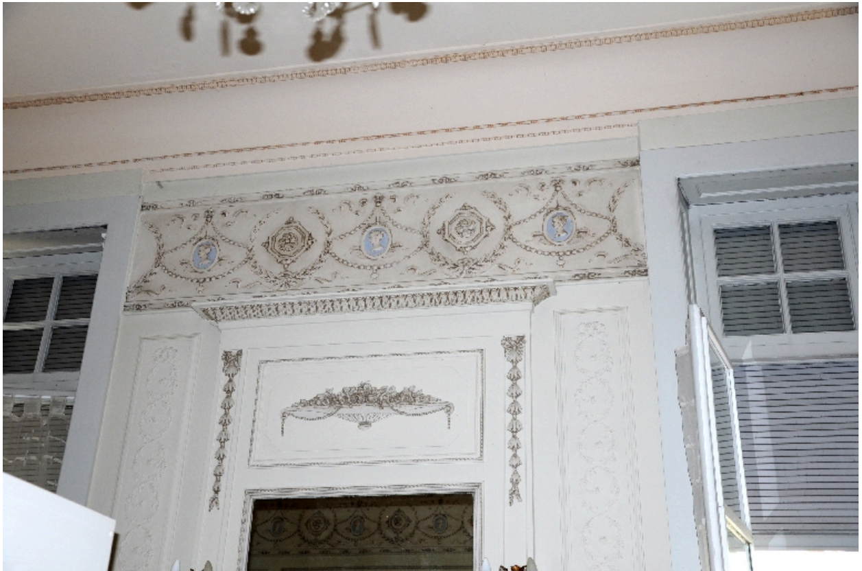
Décor d'une chambre : trumeau de cheminée
