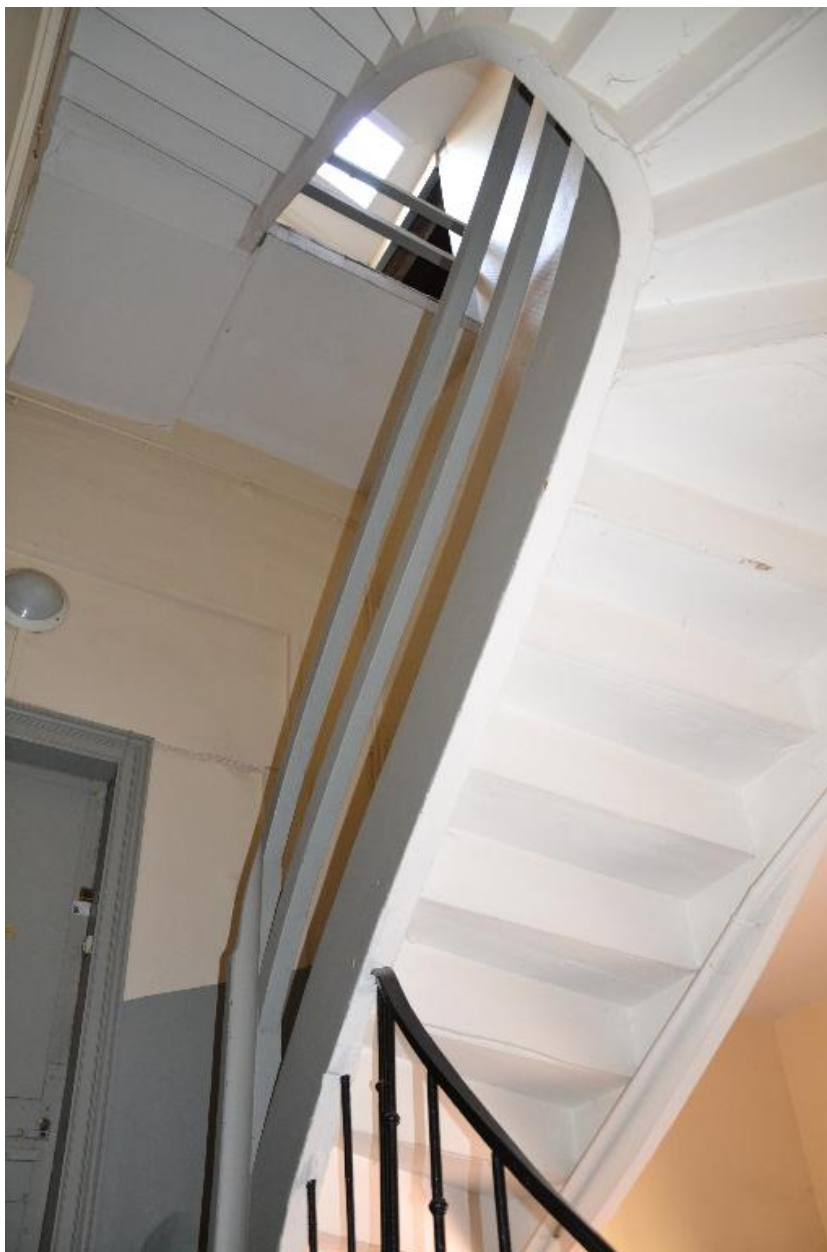
Escalier dernier niveau
