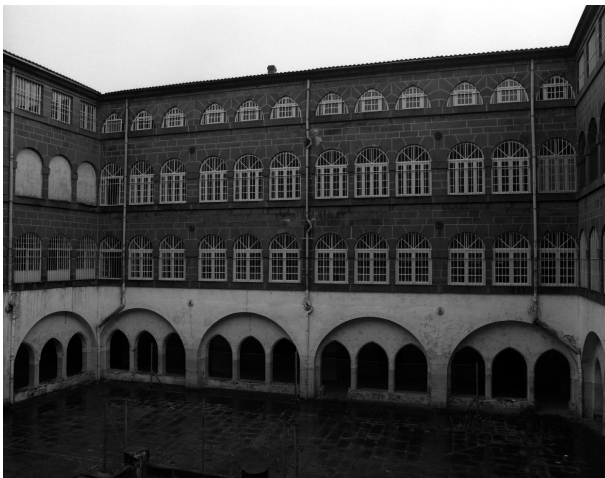
Cloître, élévation sud. Galerie du niveau de cour XVe siècle, avec surélévation du XIXe au moment de la réaffectation en prison.
