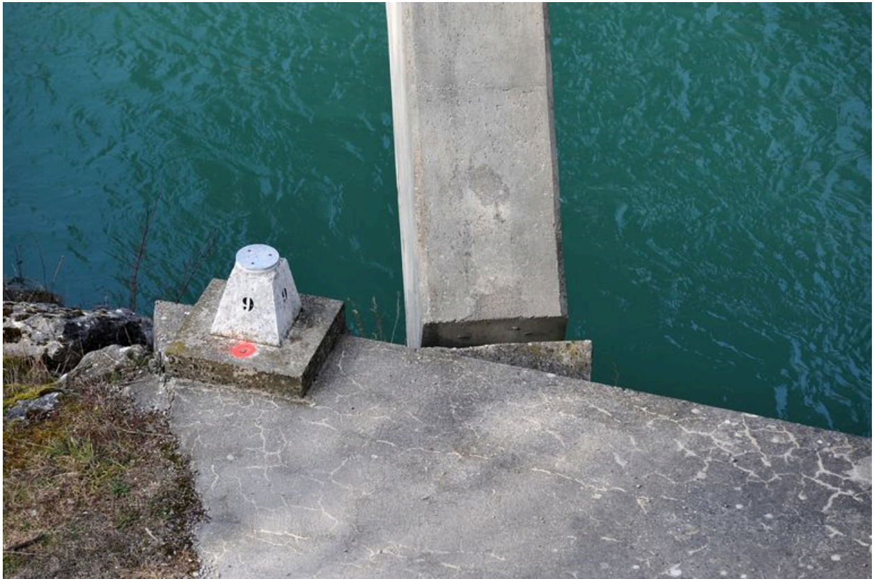
Béquille gauche, vue de détail : ancrage d'un des appareils d'appui à la rive (depuis la rive gauche)
