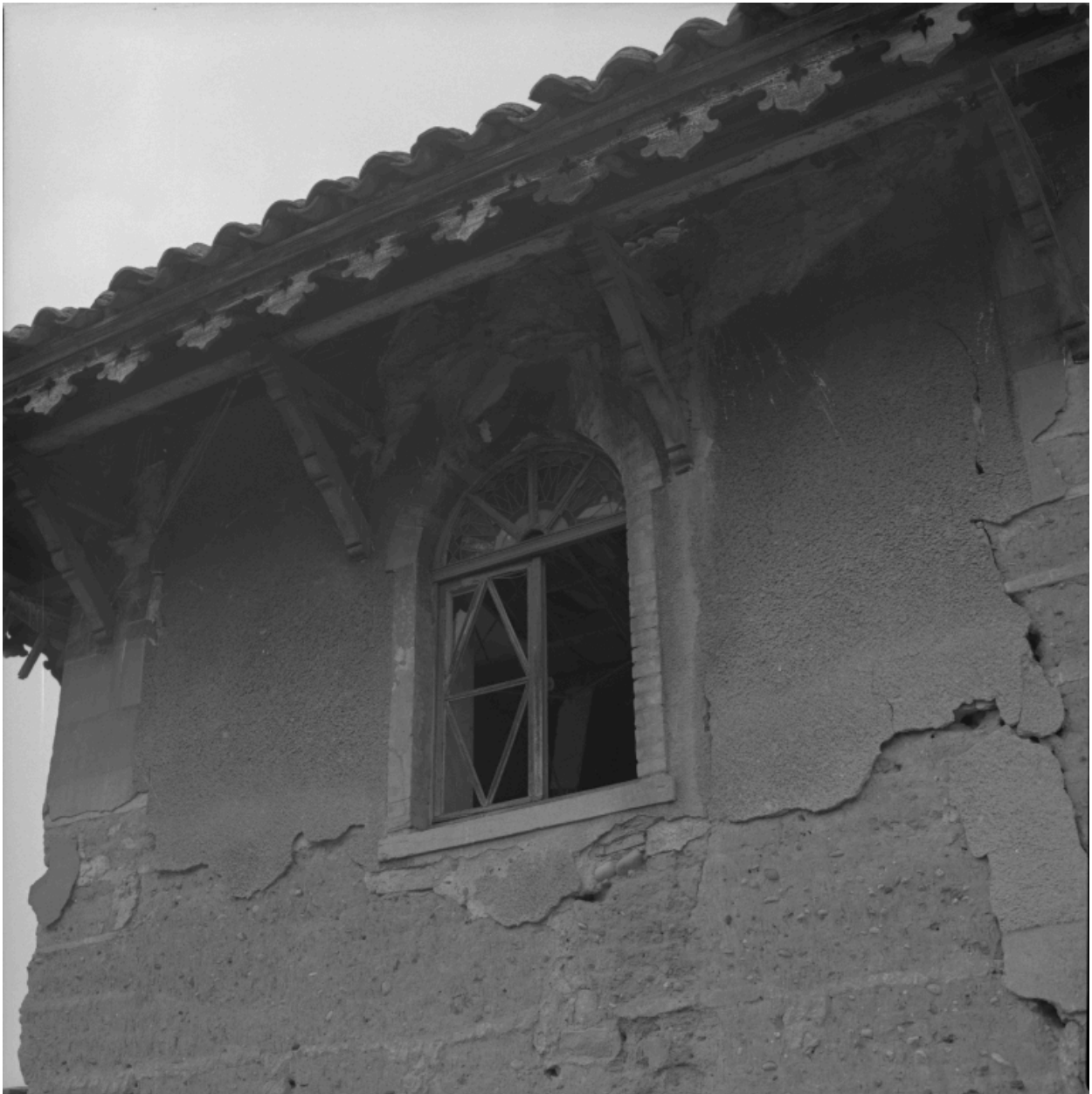
Élévation sud, détail : fenêtre au 2ème niveau, avant-toit sur aisseliers et lambrequin découpé.
