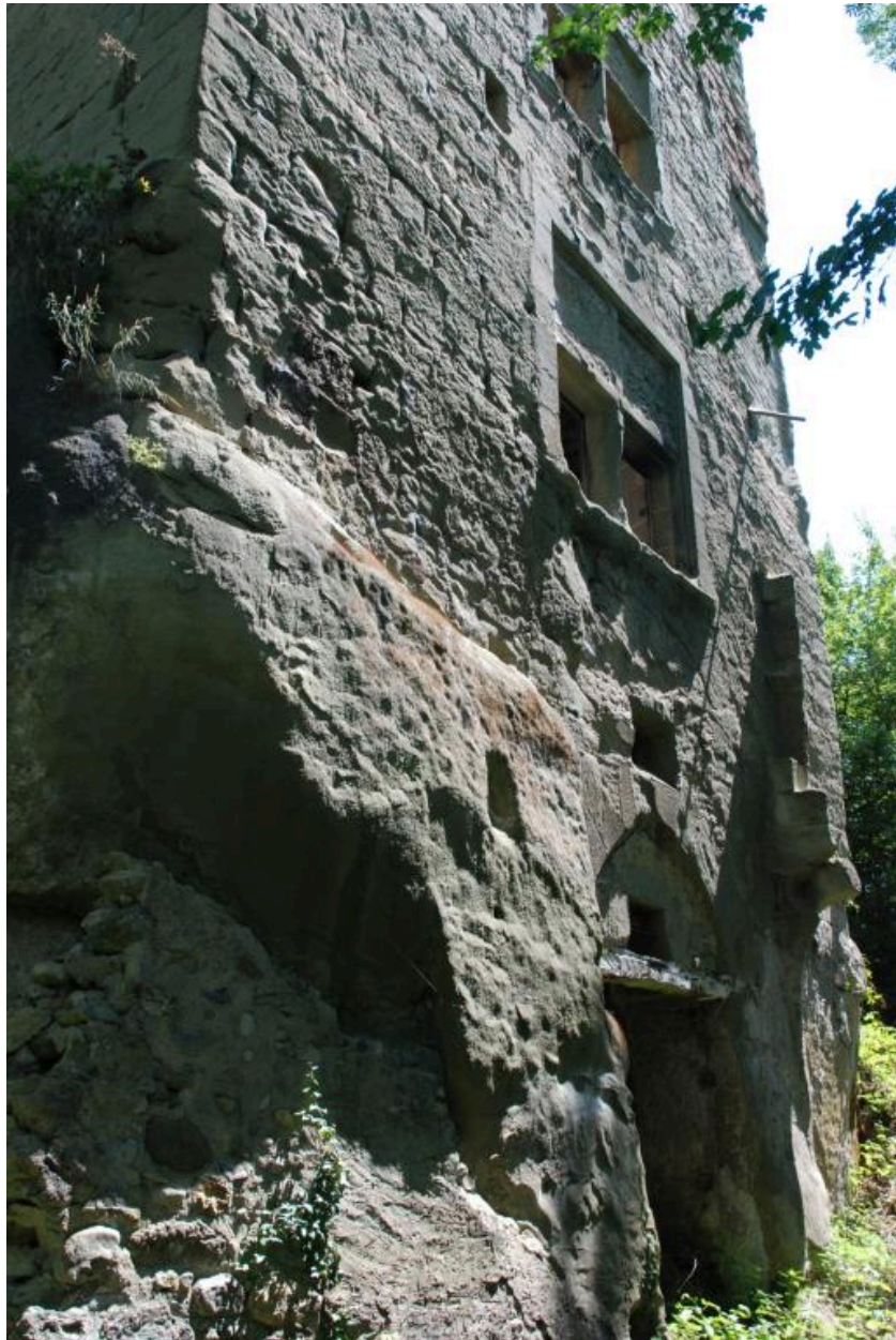
Elévation ouest, vue de l'étage de soubassement en partie creusé dans la molasse et du rez-chaussé surélevé.
