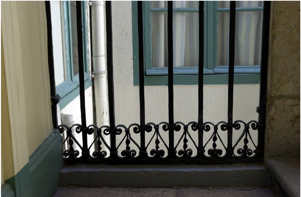
L'escalier : détail de garde-corps
