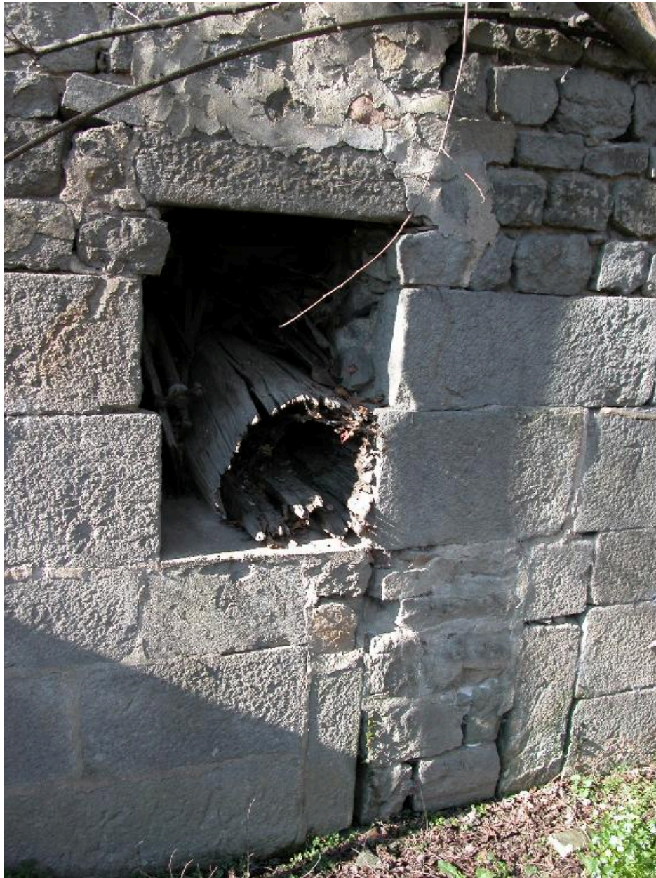
Détail de l'axe en bois de l'ancienne roue à aube du moulin.
