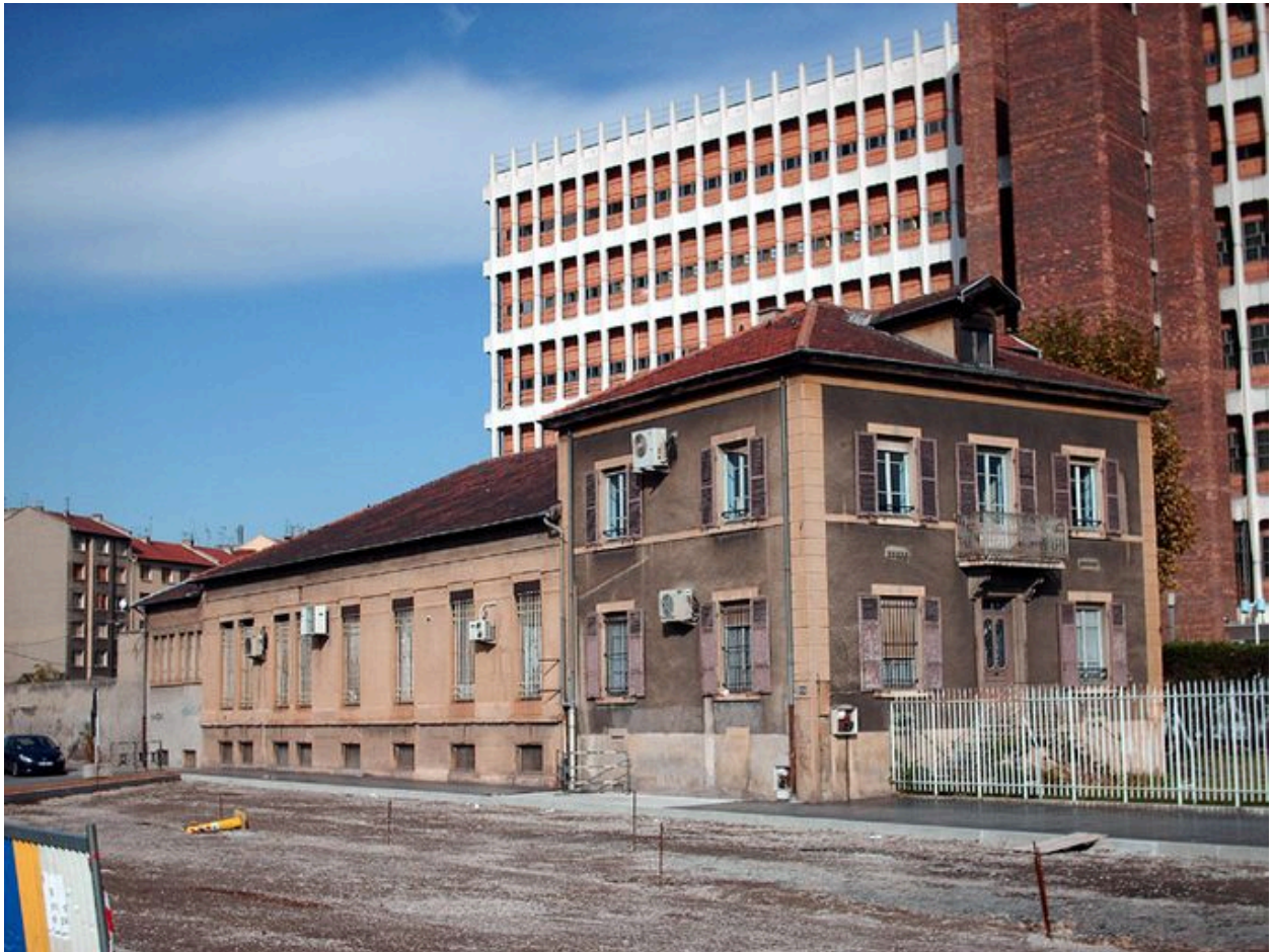
Vue d'ensemble de l'ancien bâtiment administratif des établissements Marmonier
