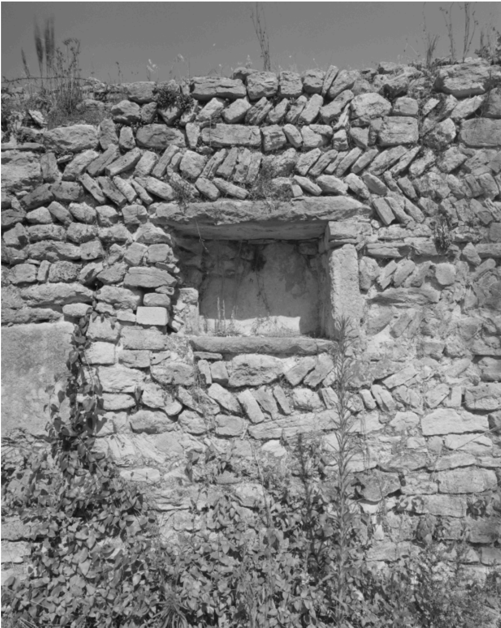
Bâtiments du prieuré, détail d'un mur de clôture.
