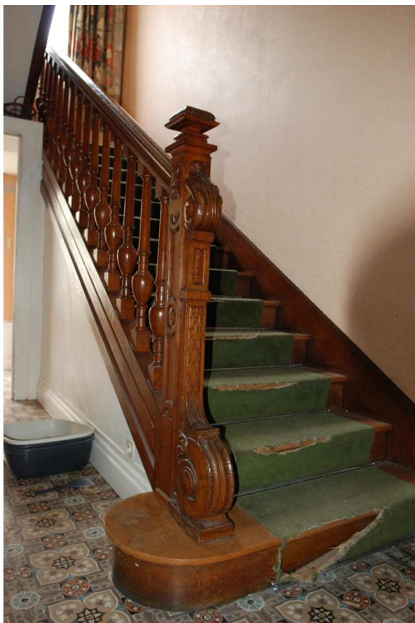
Détail rampe d'escalier
