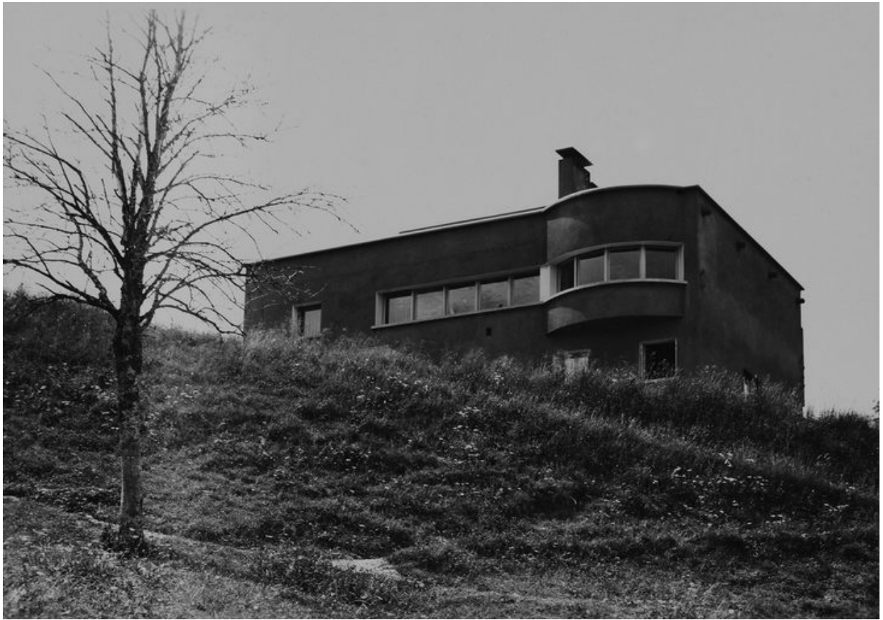
Vue d'ensemble depuis le nord-ouest. Photogr. Georges Tairraz, Chamonix, [milieu XXe siècle] (AD Haute-Savoie. 142J 575)
