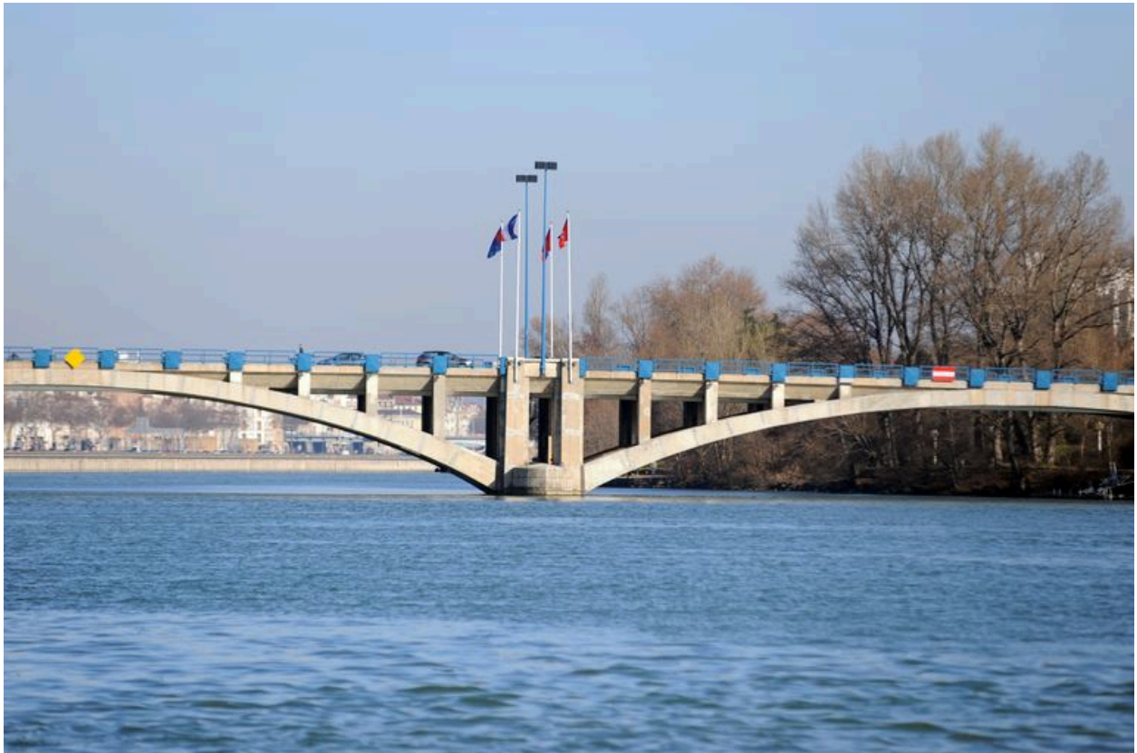
Vue partielle, pile gauche, face aval (depuis la rive droite)
