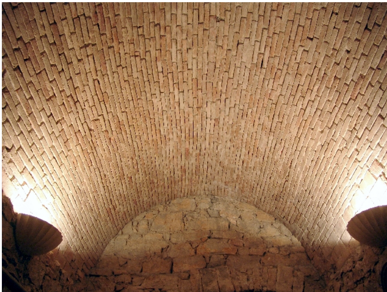
Etage de soubassement : voûte des anciennes cuisines
