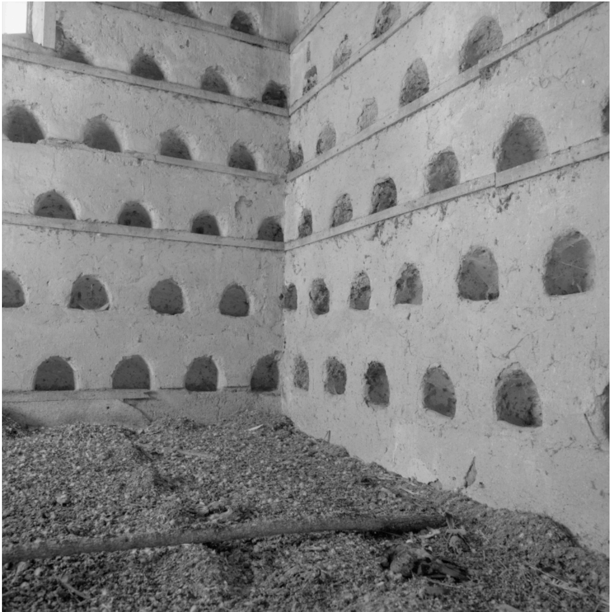
Colombier, vue intérieure.
